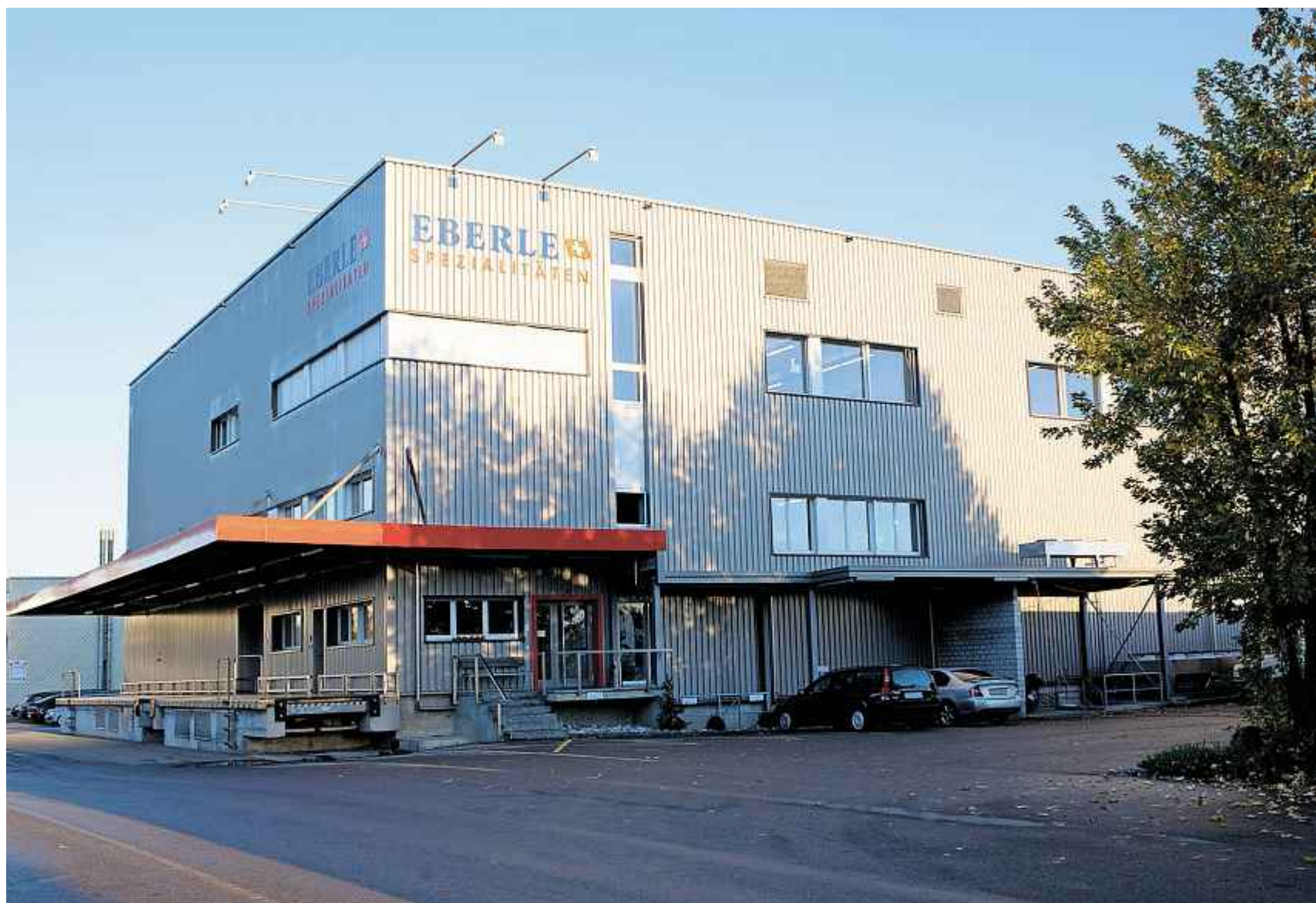
Das Produktionsgebäude in Gossau entspricht allen Anforderungen und bildet die Basis für eine betriebliche Zukunft.
